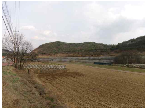
3공구 패널식 옹벽 02
