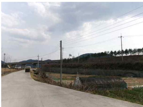
3공구 블럭식 옹벽 03
