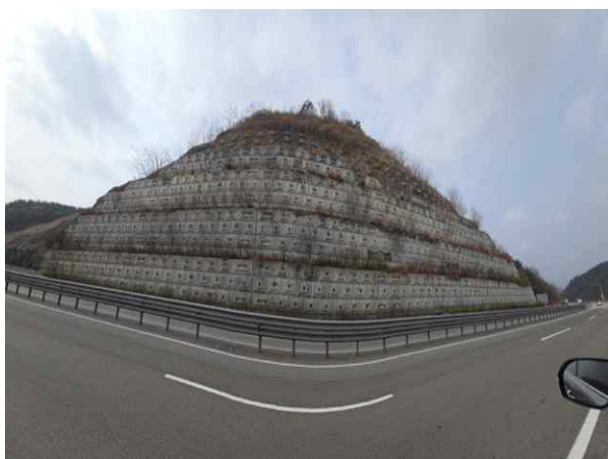
4공구 패널식 옹벽 05
