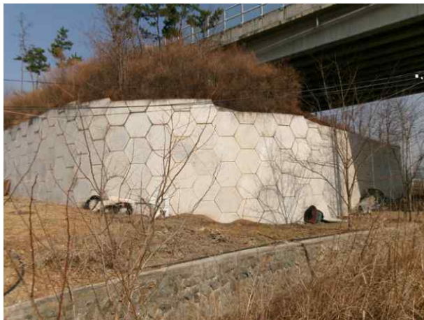
9공구 패널식 옹벽 15
