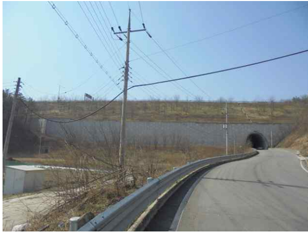
8공구 패널식 옹벽 13
