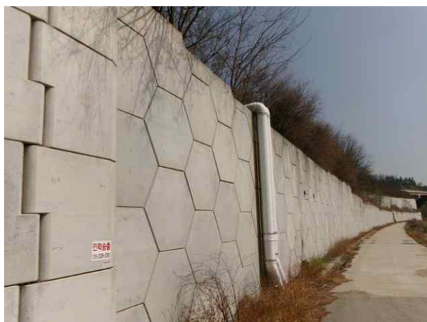
7공구 패널식 옹벽 12
