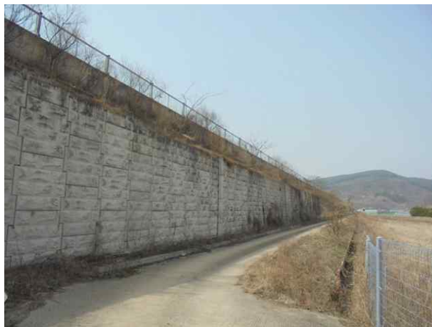
6공구 패널식 옹벽 08
