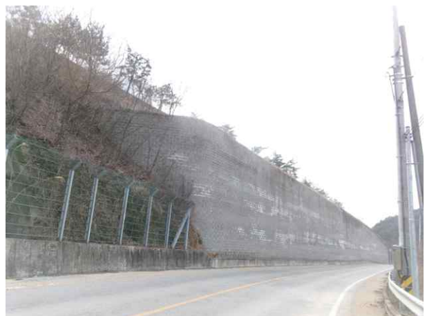
4공구 블럭식 옹벽 04
