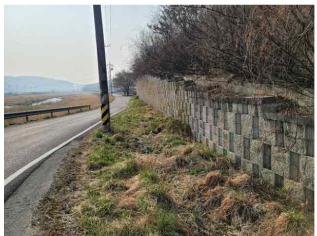
5공구 블럭식 옹벽 06
