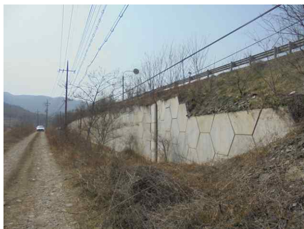
7공구 패널식 옹벽 11
