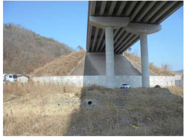
8공구 패널식 옹벽 14
