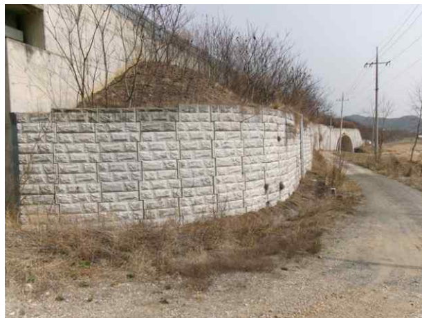
6공구 패널식 옹벽 07
