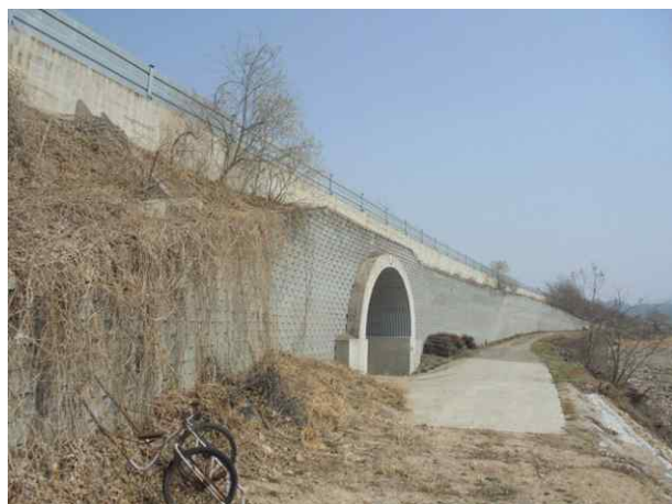
6공구 블럭식 옹벽 09
