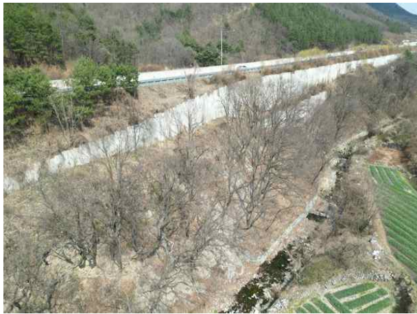
3공구 패널식 옹벽 01
