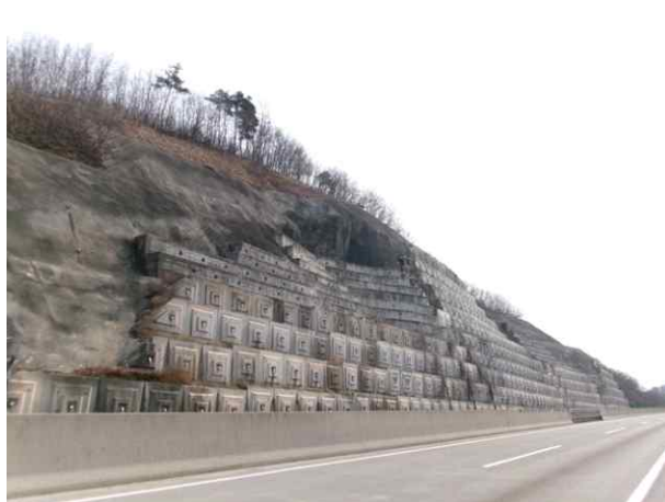
6공구 패널식 옹벽 10
